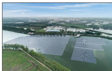
รูปที่ 4 พลังงานแสงอาทิตย์บนทุ่นลอยน้ำ NPS ที่มา: 304 อินดัสเตรียล ปาร์ค, 2567
